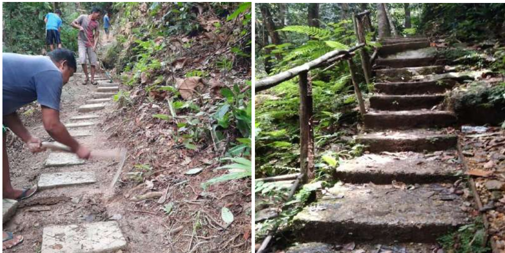
Pembuatan jalan dari balok semen menuju air terjun agar tidak curam
